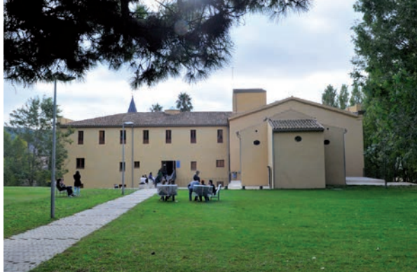
Campus de la Alimentación de Torribera
