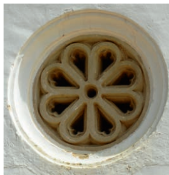
Detall del respirador de la torre d'aigües de la Misericòrdia (Canet de Mar).
