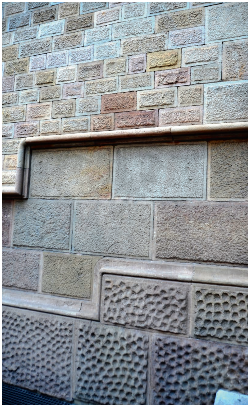
Imatge de les diferents textures i formes de treballar la pedra a la façana de la casa Serra (Barcelona).
