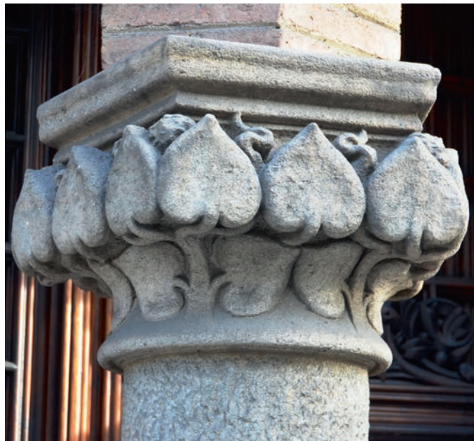
Capitell exterior de la casa Terradas (Barcelona).
