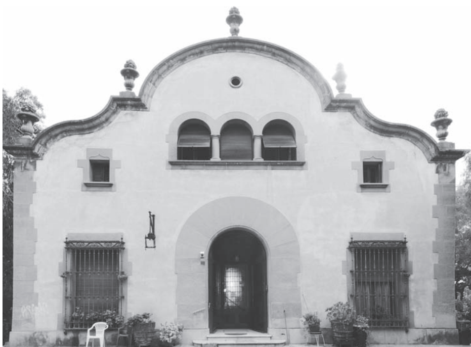
Figura 2. Vista frontal de la façana nord.
