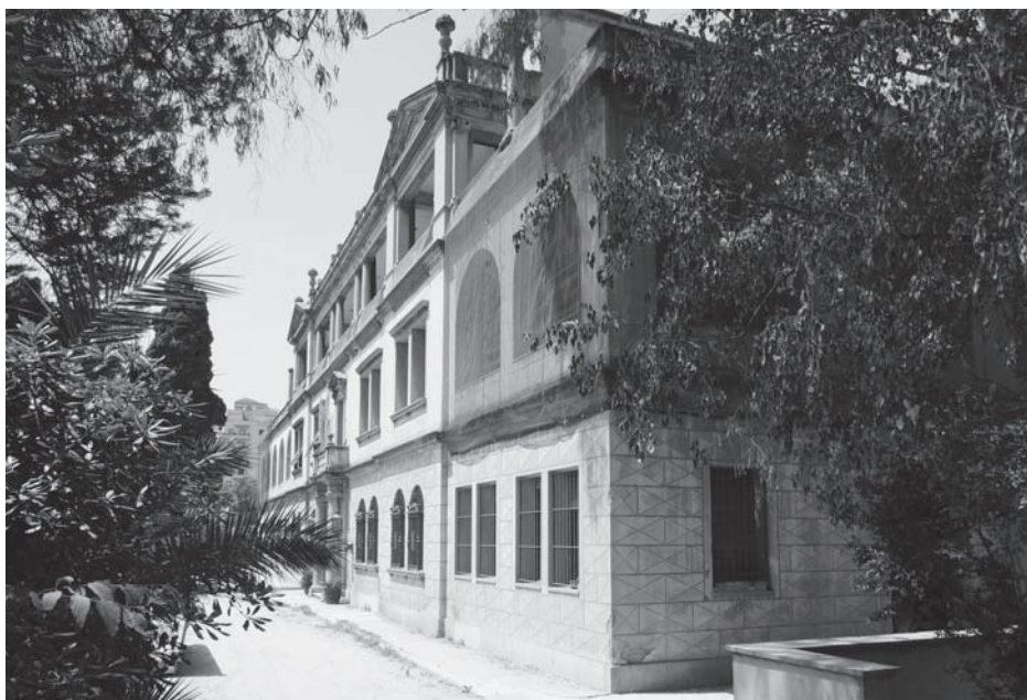
Figura 1. Vista lateral de la façana sud de l'Institut Ravetllat-Pla.
