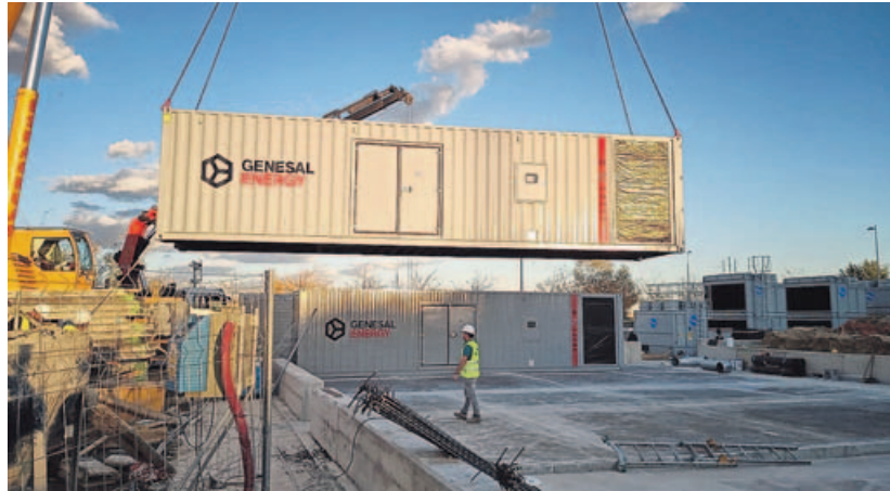
Momento de la instalación de los grupos de emergencia en el hospital madrileño, inaugurado el 1 de diciembre.
